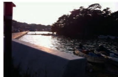
会場の海側は、震災で地盤沈下したため、真新しい堤防が嵩上げされており、復旧工事が続いている。
